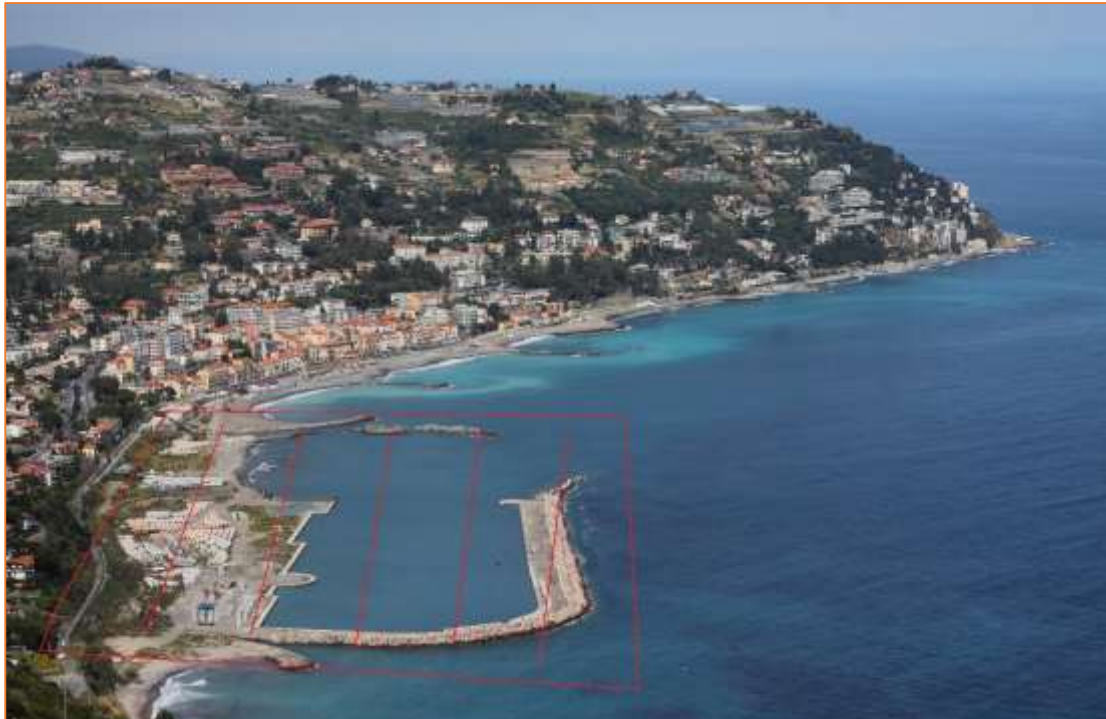
Lo scheletro del mega porto di Ospedaletti, eco-mostro che ha provocato incalcolabili danni all'ambiente e all'economia locale. Drammatico tempio allo spreco di denaro pubblico e alla devastazione ambientale.
