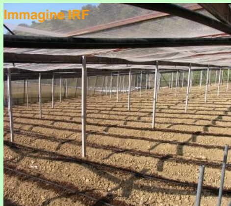
Impianto di anemoni in fase di allestimento
