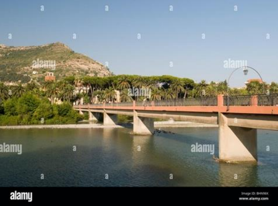
Vecchia passerella in piano bassa, di circa 5 Metri di altezza, solare, non impattante, con pergolato, in stile 900 realizzata interamente in calcestruzzo come i ponti vicini
