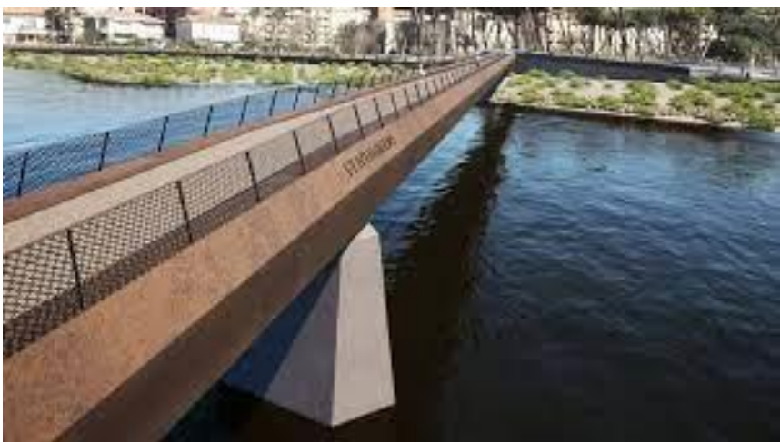
Vista passerella monoblocco, con parte centrale rialzata, a 8 metri circa, che appoggia su area allagabile, e alberi in crescita, realizzata con trave , e chiusura in acciaio Corten, di colore irrealistico (non naturale) a proiezione triangolare, verso l’interno, con restringimento del, passaggio dovuto all’inclinazione e l’utilizzo di una rete di tenuta
