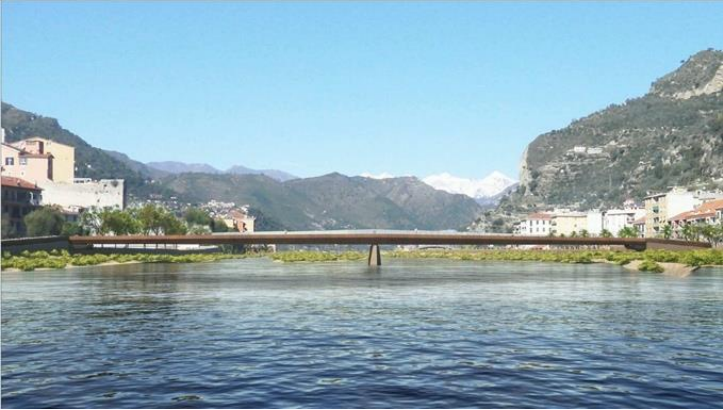
Nuovo progetto passerella nello stile contemporaneo, rialzata a 8 metri di altezza, in pendenza, con travi e impalcato in acciaio Corten, e pilastro e spalle in calcestruzzo, dai colori cupi, totalmente differente dalla vecchia passerella.
