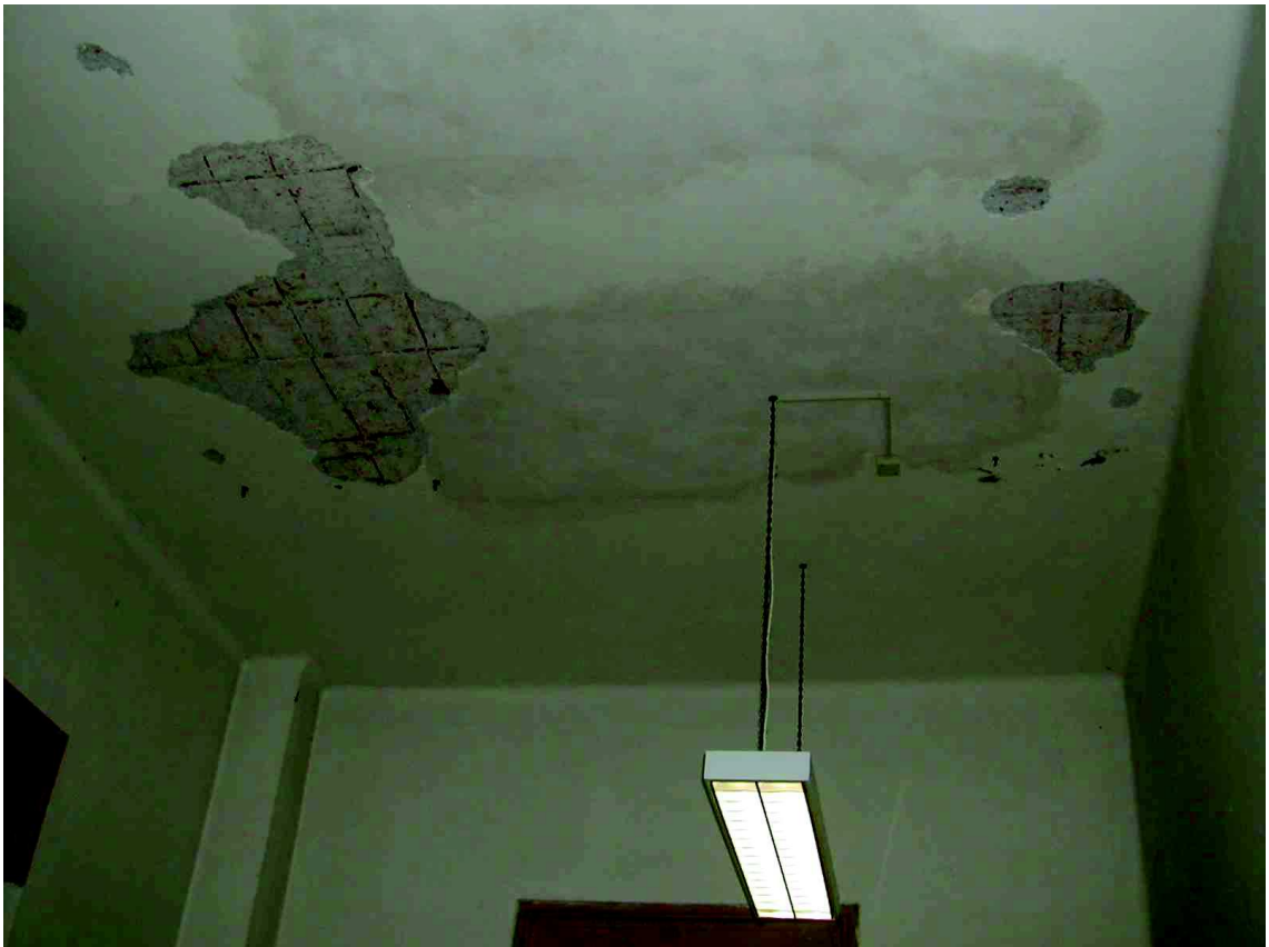
Ripresa fotografica di soffitto soggetto a risanamento con controsoffitto
